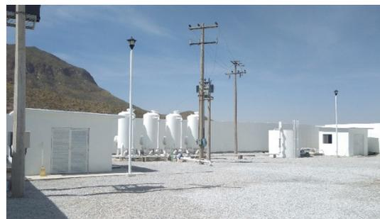
**Imagen 5.2-D.** Planta potabilizadora de filtración directa a presión del pozo 15 Pueblo Nuevo, Gómez Palacio, Durango.
