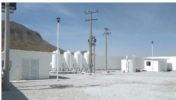
**Imagen 5.2-A.** Planta potabilizadora de filtración directa a presión del pozo Alamito en Francisco. I. Madero, Coahuila.
