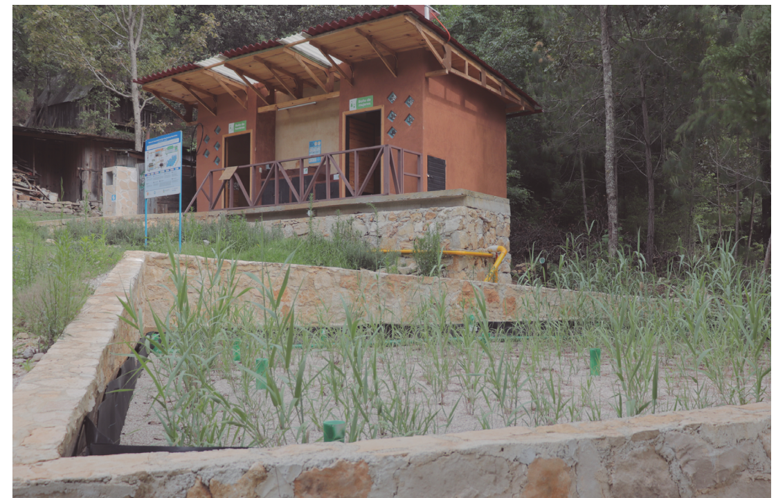
Imagen 7: Humedal construido en el parque Encuentro en San Cristóbal de Las Casas, Chiapas.
