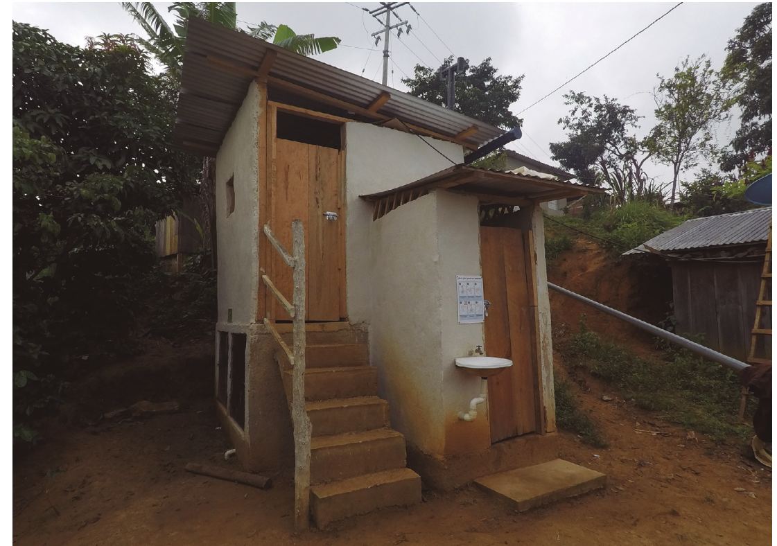
Imagen 6: Baño seco construido en Sitalá, Chiapas.
