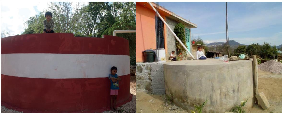
Imagen 7.1. Captación pluvial y cisternas escala doméstica en Morelos
